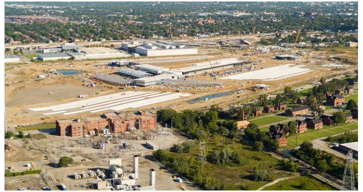
Construcción del Punto de entrada estadounidense
