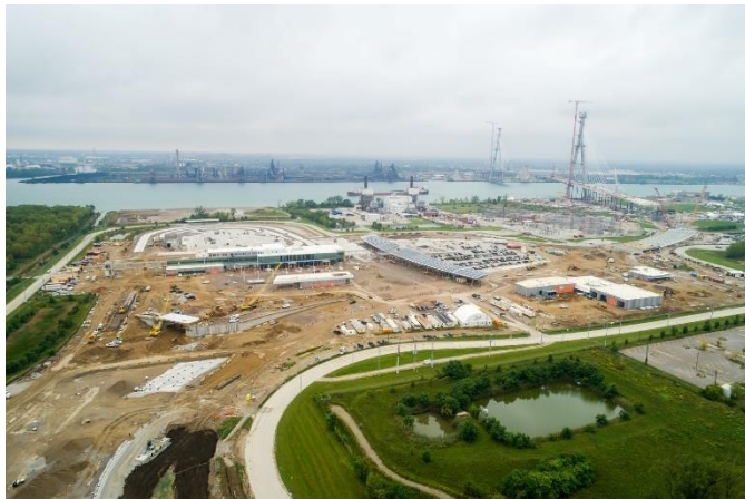
Construcción del Punto de entrada canadiense
