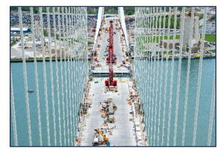
**Paso 10:** Se instalan paneles prefabricados de hormigón y se terminan
