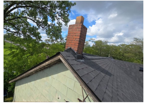
Una reparación de techo completada a través del Programa de mejoras para las viviendas de Delray.
