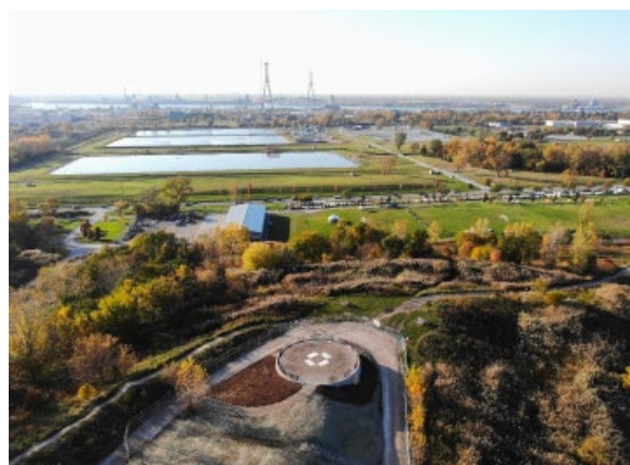
A la derecha se puede ver una vista aérea del área durante la construcción. En la portada del informe se incluye una fotografía del mirador ya completo.
