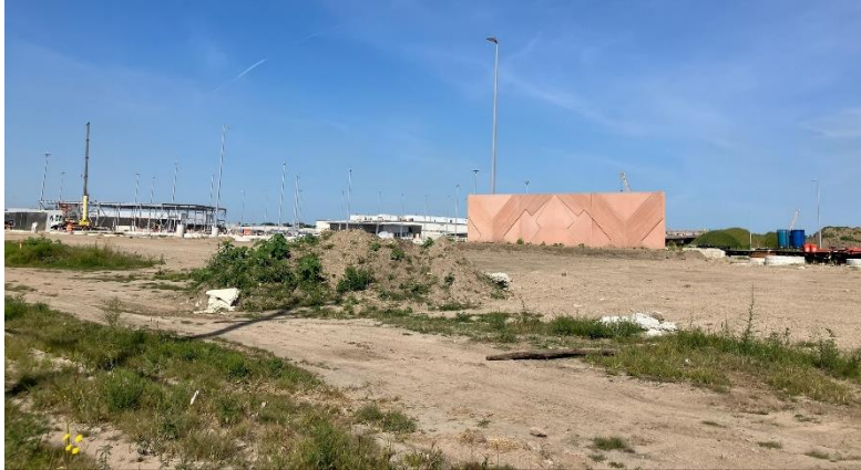
Construction du mur d'enceinte de l'avenue Jefferson.
