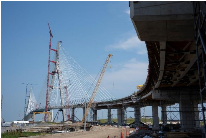
Le Pont international Gordie Howe en cours de construction.
