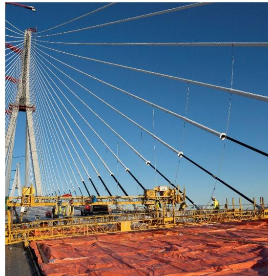
*Obra de pavimentación en la plataforma del puente*
