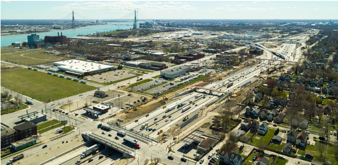
Avance de la construcción en la I-75
